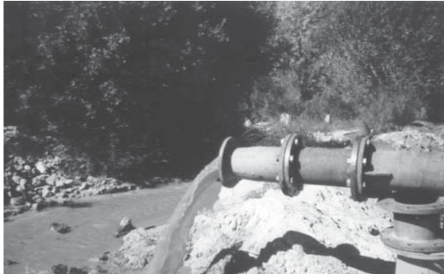
Figura III.4.11. Acidificación en pozo. Valdentaies-Madrid (España).
