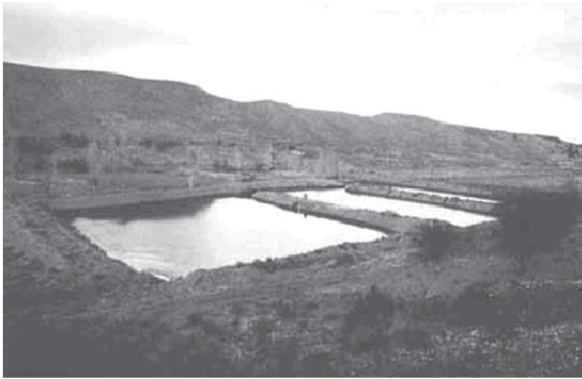
Figura VI.7.1. Balsas de recarga en el acuífero detrítico del río Verde Guadix, Granada. España (ITGE, 2000).
