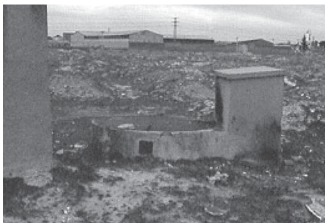
Figura III.4.1. Pozo excavado de gran diámetro.
