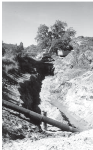
Figura III.4.3. Zanja de drenaje
